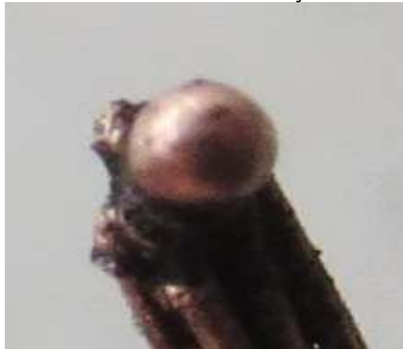
Figura 06 – Condutor de cobre – Traço de fusão primário
