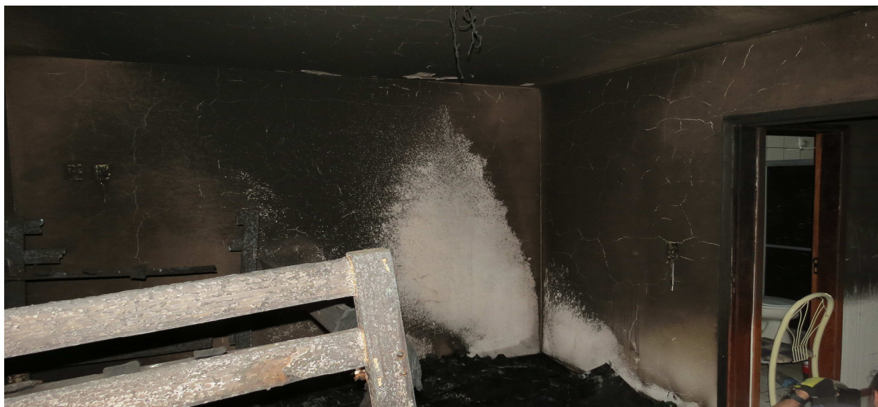
Figura 19 – Marcas na parede com maior intensidade de queima – local onde original de um guarda-roupas.
