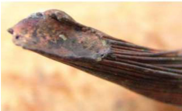
Figura 08 – Condutor de cobre. Traço de fusão encontrado em incêndio real que foi causa.
