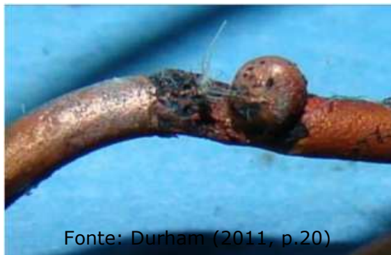
Figura 09 – Traço de fusão energizado resultado do incêndio
