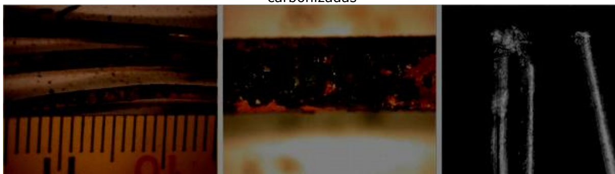
Figura 4 - Danos causados nos condutores por arcos elétricos através de superfícies carbonizadas
